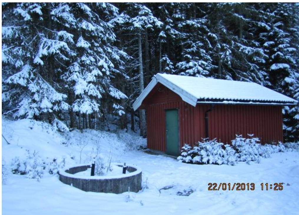
Bildet viser vannrenseanlegget ved Blanketjern
